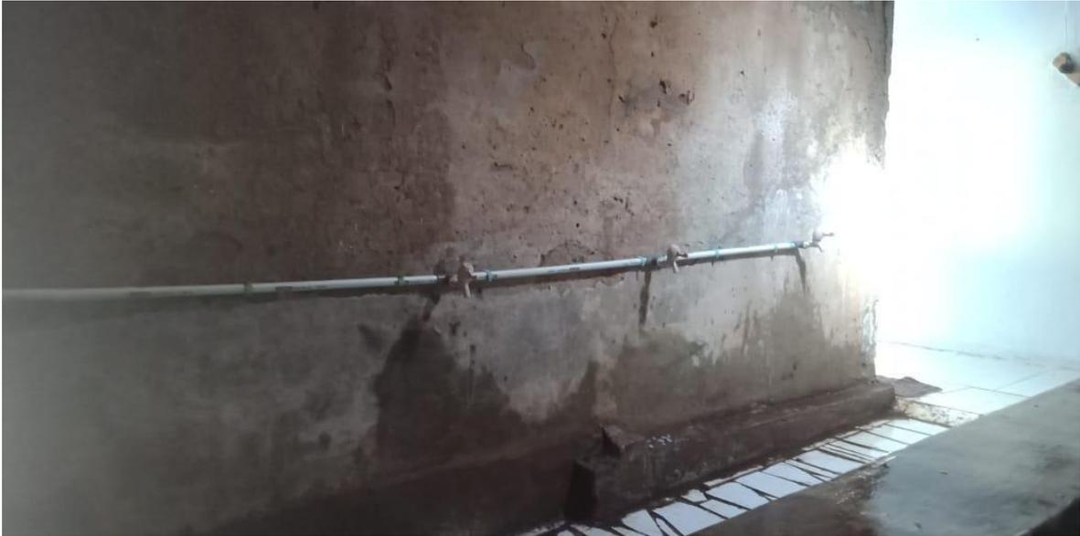
Gambar 13. Pemasangan kran air
