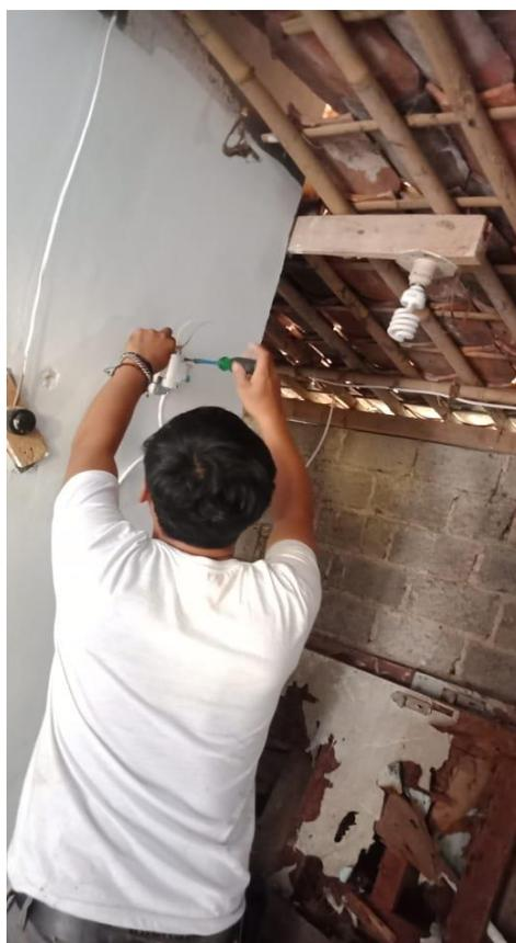
Gambar 16. Pemasangan sakelar pompa air
