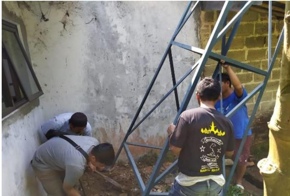
Gambar 7. Pemasangan tower tangka air
