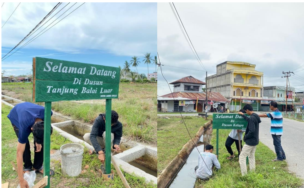
Gambar 4. Pengecoran dan pemasangan plang nama jalan
