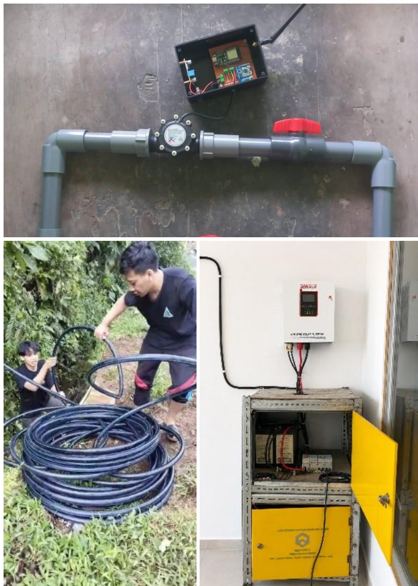
Gambar 5. Pemasangan perangkat pada jaringan distribusi air dan keterlibatan mitra.
