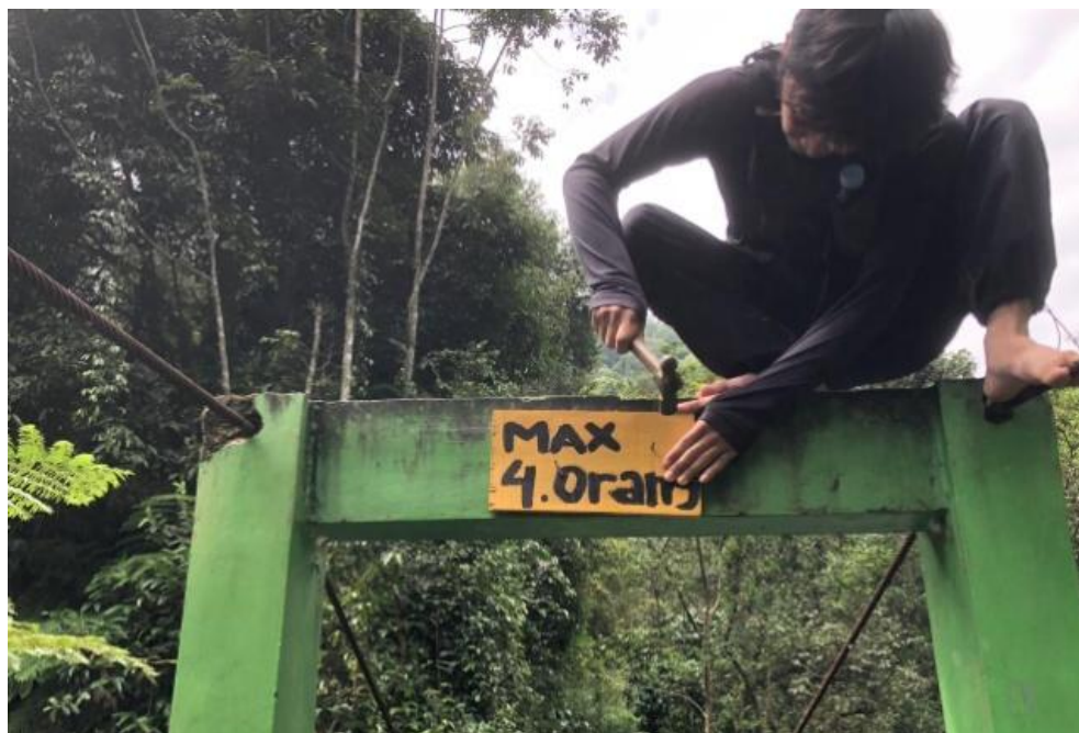
Gambar 8. Proses Pemasangan Papan Informasi Himbauan Maksimal Jumlah Orang di Jembatan Penyebrangan
